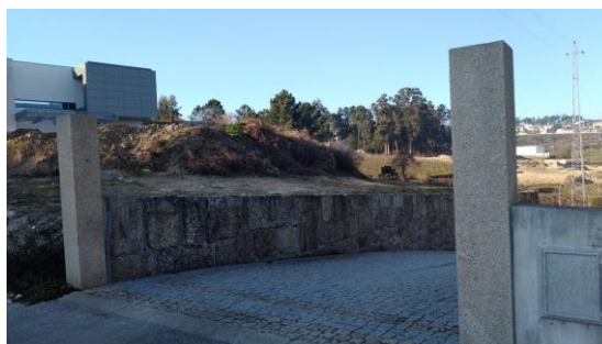
Portão de entrada
